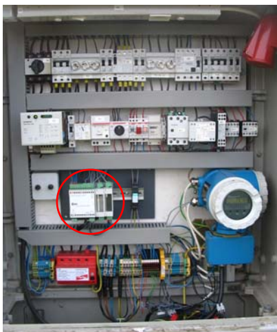
Abb.: Kompakte MFW-Module in einem Freiluftschaltschrank an einem Brunnen
